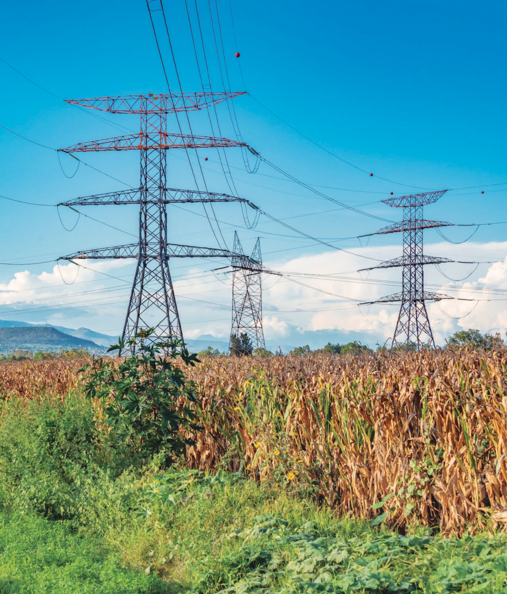
Torres de transmisión , Tula, Hidalgo. Comisión Federal de Electricidad.
