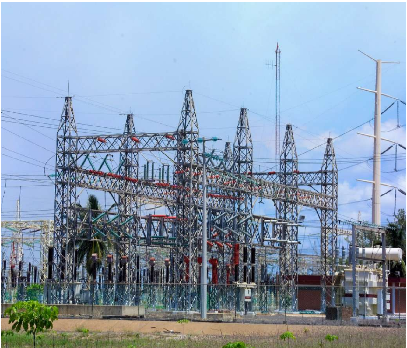
Subestación eléctrica, Tuxpan Veracruz, 2005. Comisión Federal de Electricidad.
