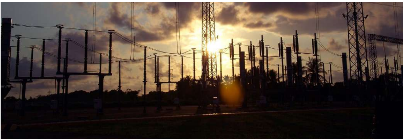
Subestación eléctrica, Tuxpan Veracruz, 2005. Comisión Federal de Electricidad.
