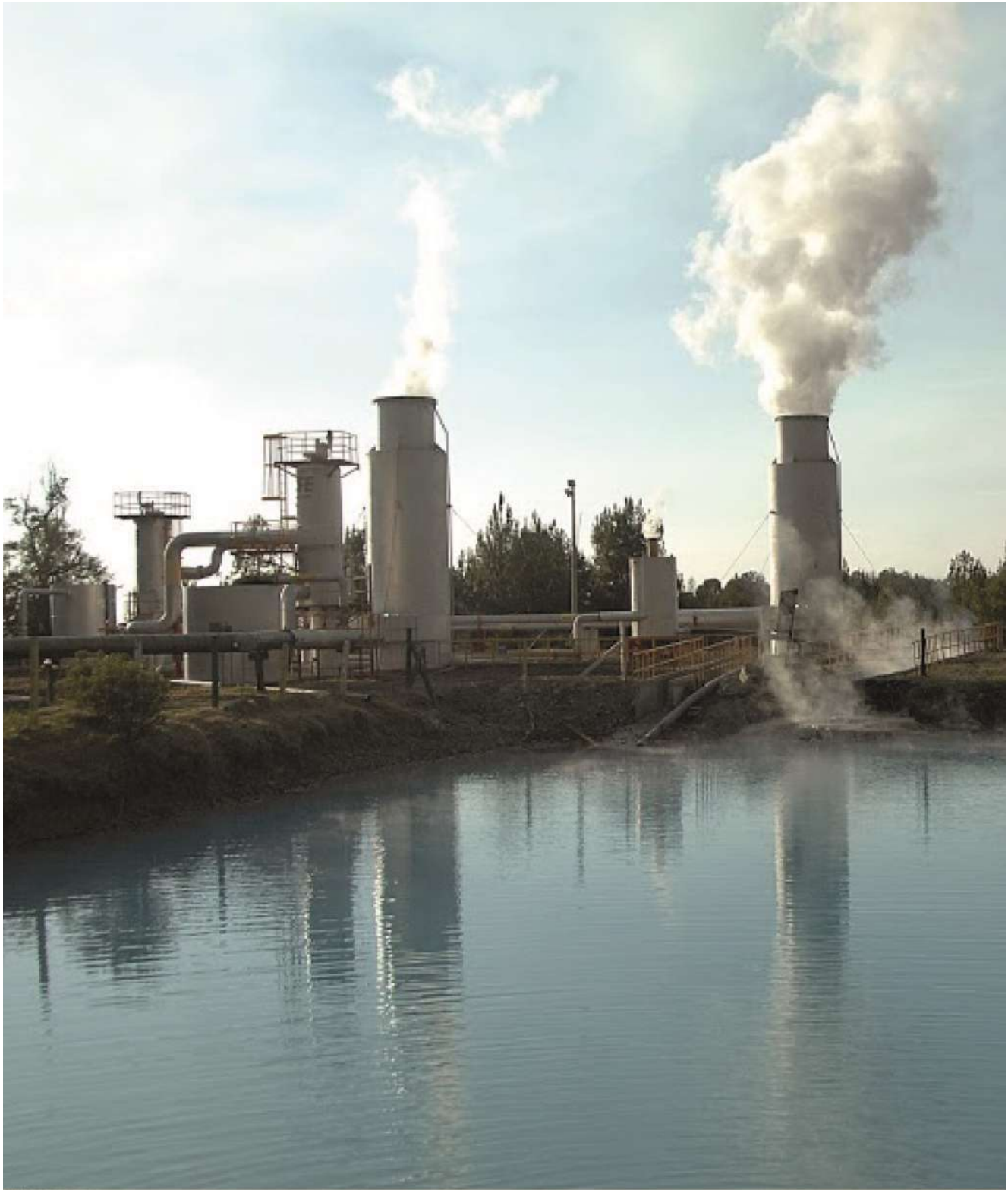
Central geotérmica, Los Hornos, Puebla. Comisión Federal de Electricidad.
