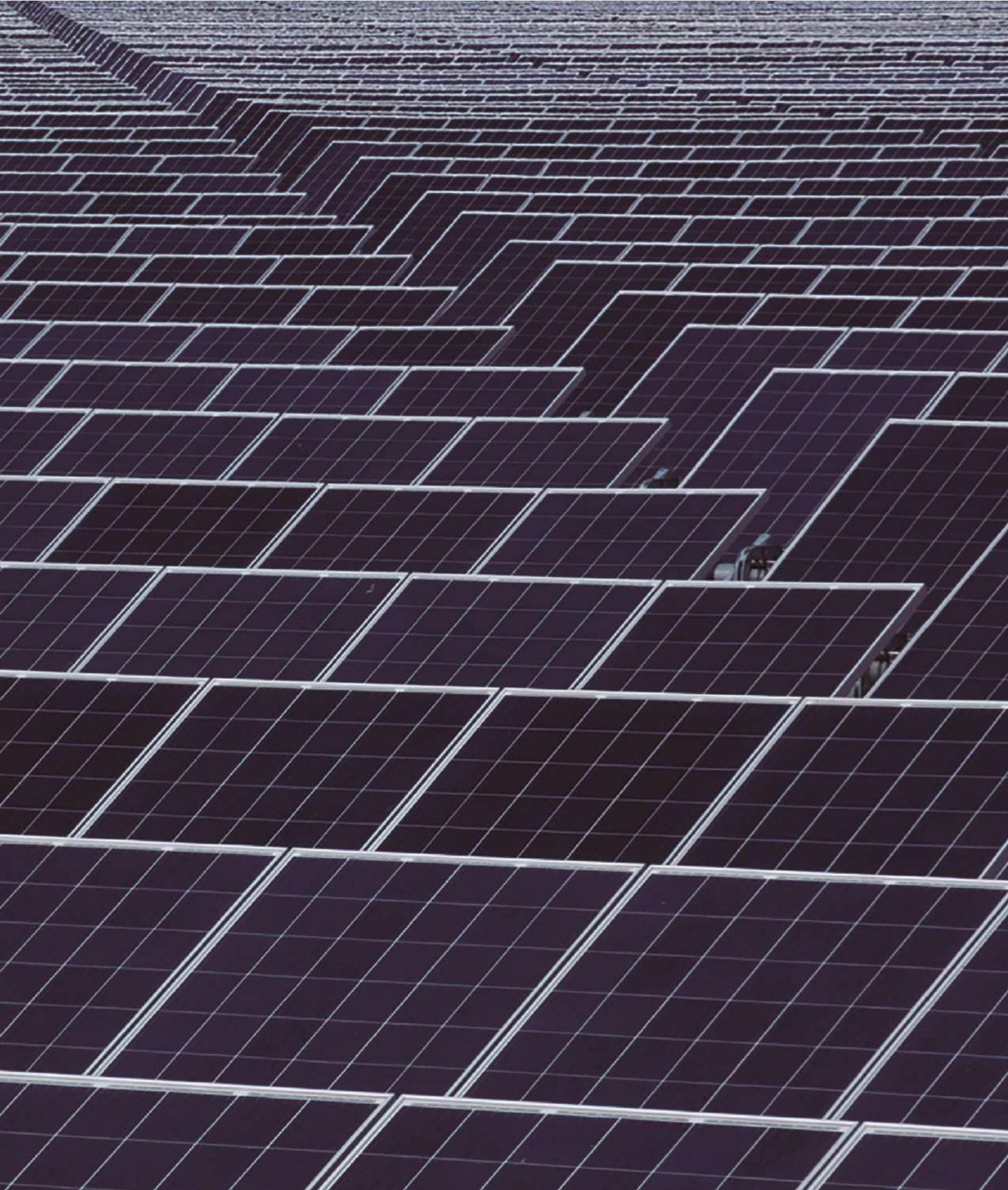
Parque fotovoltaico, Hermosillo, Sonora. Comisión Federal de Electricidad.
