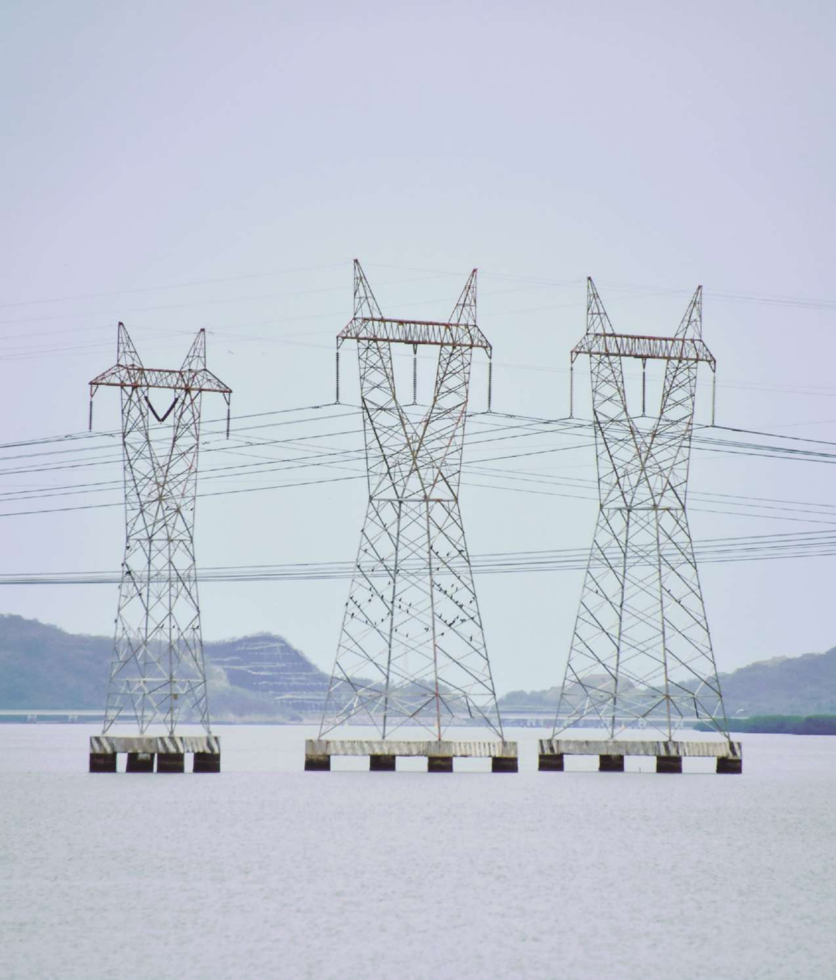
Torres de transmisión, Manzanillo, Colima. Comisión Federal de Electricidad.
