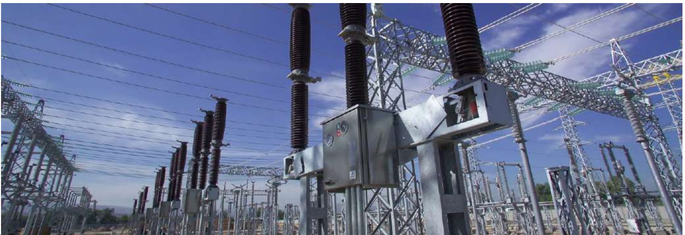
Subestación eléctrica "Los Azufres", Michoacán, 2006. Comisión Federal de Electricidad.
