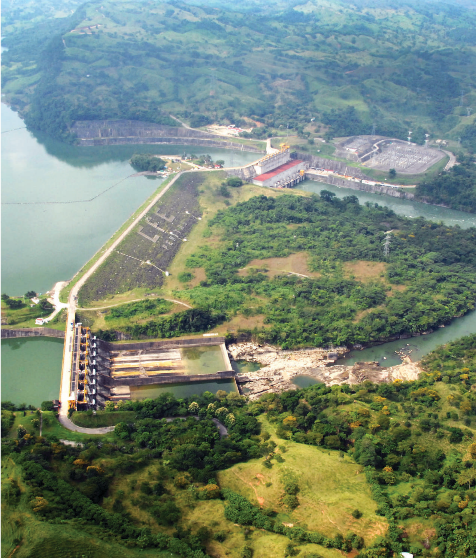
Central hidroeléctrica, Peñitas, Chiapas. Comisión Federal de Electricidad.
