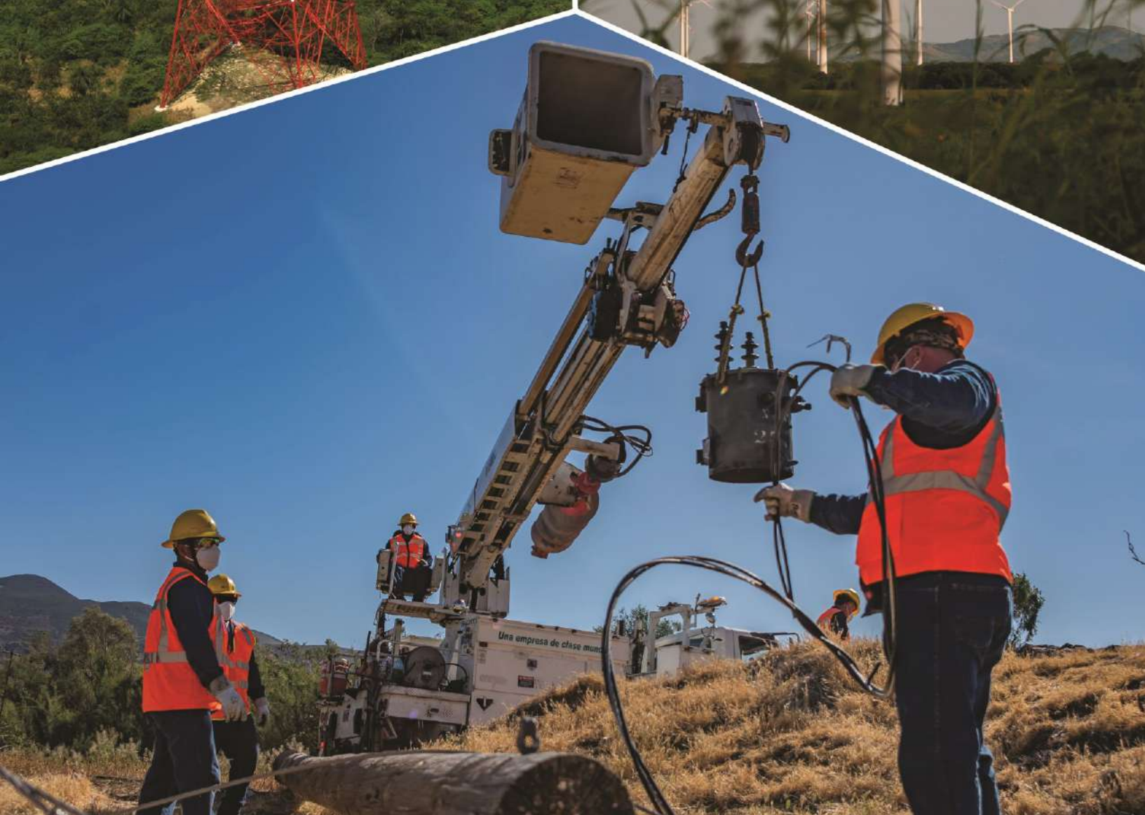
Torre , La Ranita, Chiapas. Central eólica , Juchitán, Oaxaca. Maniobra de distribución , Tijuana, Baja California. Comisión Federal de Electricidad.
