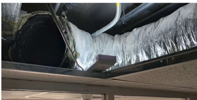
2 Ejemplo ducto tubular
